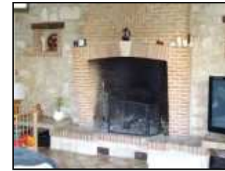
Conduit de cheminée
