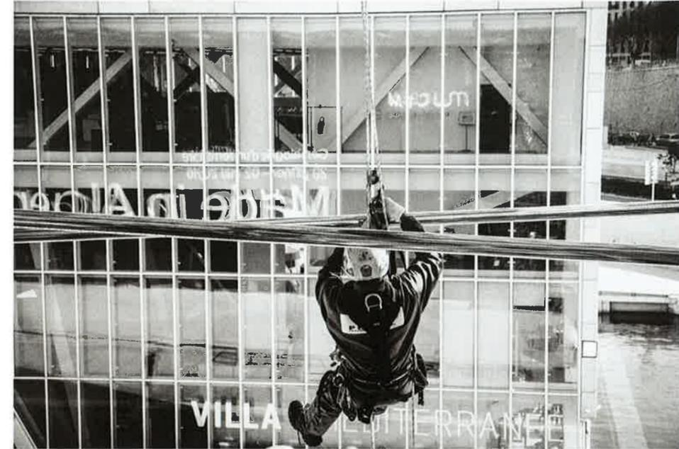
Après s'être positionné, le cordiste ajuste son matériel et règle ses agrès. Sensible au sel de mer et à l'oxydation, les tangons de maintien du voile béton du Mucem exigent un entretien régulier (nettoyage et serrage par clé dynamométrique).
